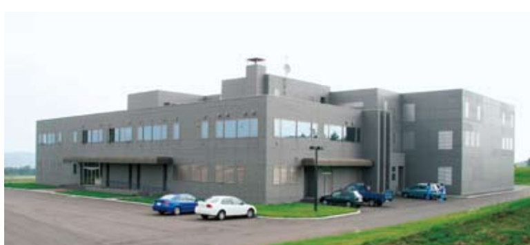
長幌上水道企業団第1浄水場
