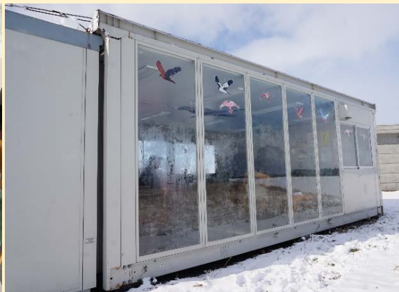
鳥の駅に設置されたバードセーバー
