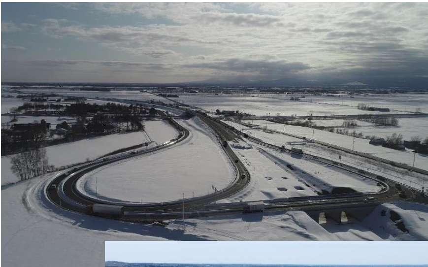
道央圏連絡道路（泉郷道路長沼ランプ）
