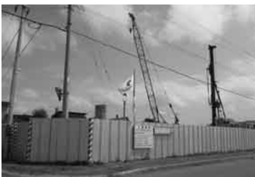
工事が始まった宮下南団地建替工事の現場
