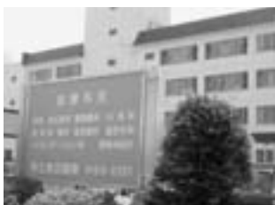
老朽化が進む町立病院
