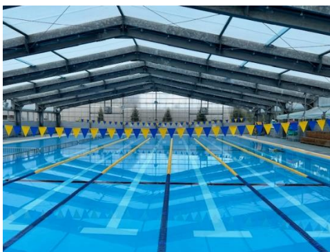
中央長沼水泳プール
