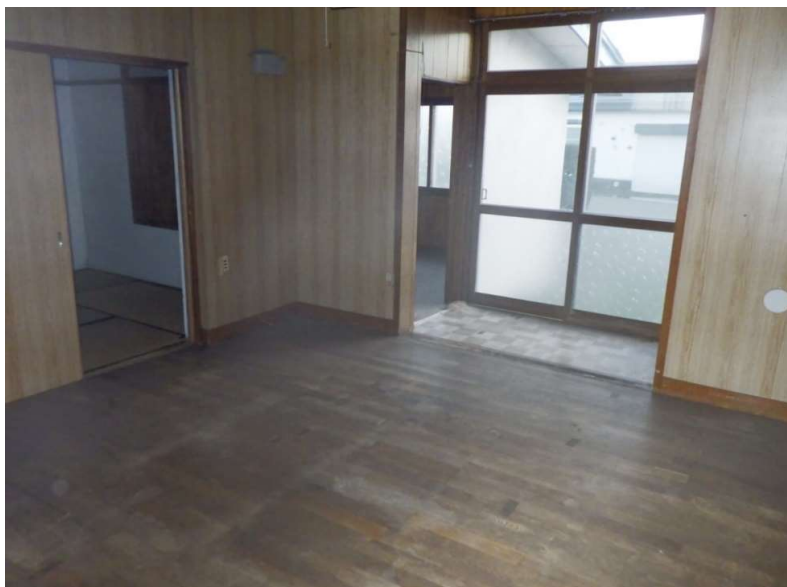
栄町排水機場住宅 1号 (北東側)
