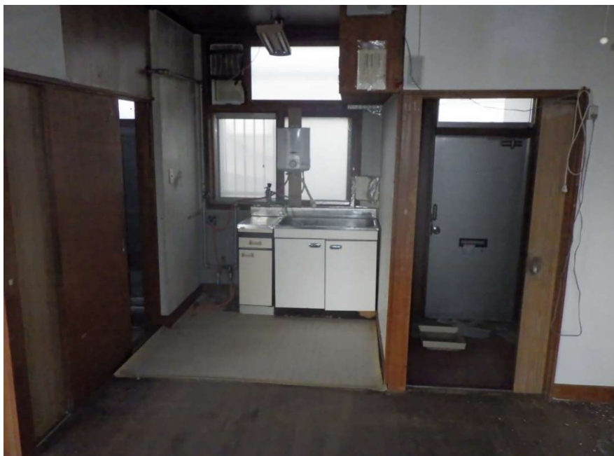
栄町排水機場住宅2号（南西側）
