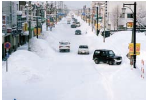
平成11年 融雪溝設置（供用開始前）
